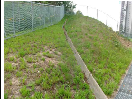
<배수로U 형 전경>
