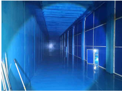
<배수지 1지 전경>
