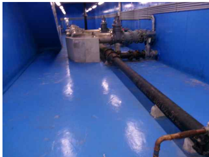
<유출밸브실 바닥슬래브 망상균열>
