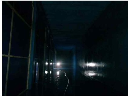
<배수지 2지 전경>
