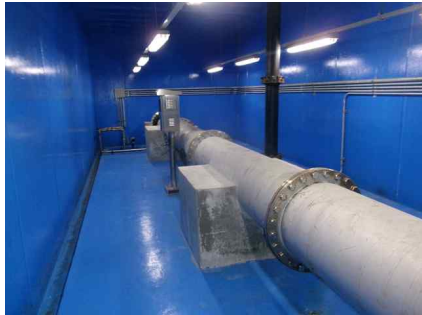
<유출밸브실 지하1층 전경>
