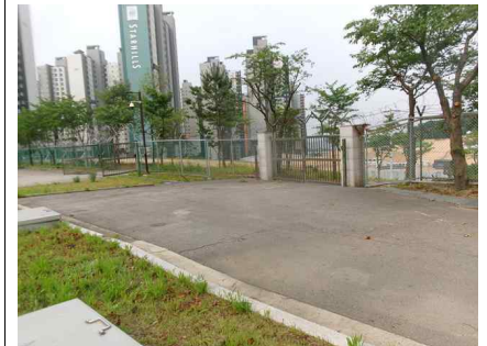
<진입로 포장 현황>
