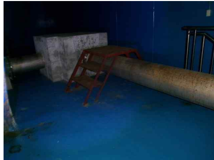
<유입밸브실 지하2층 전경>
